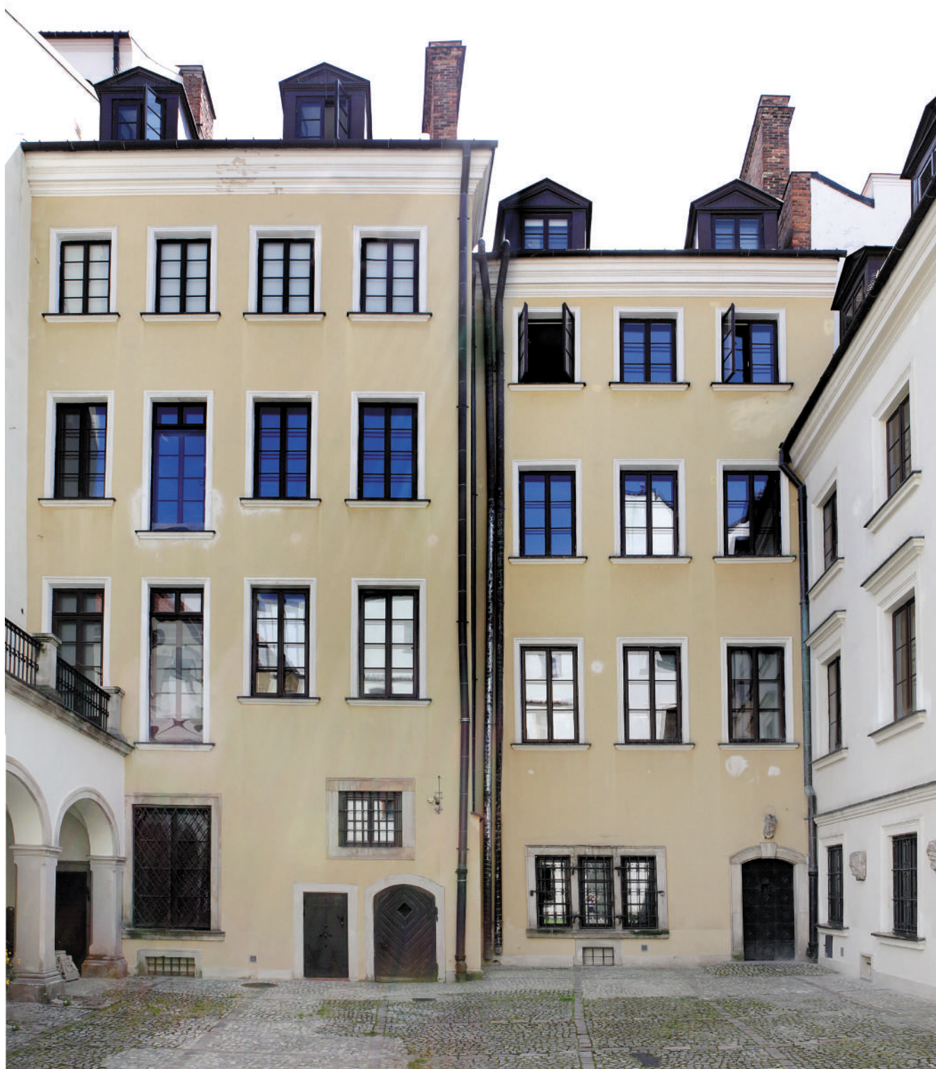
Lapidarium, elewacja S-E, lipiec 2013 r.
