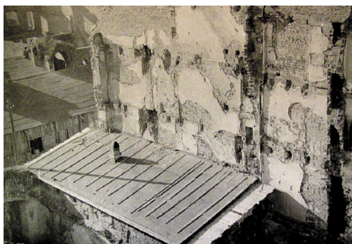
Fragment dziedzińca kamienicy Kurowskiego (38, LAPIDARIUM), widok z balkonu kamienicy 38 w kierunku ulicy Nowomiejskiej; 1951
