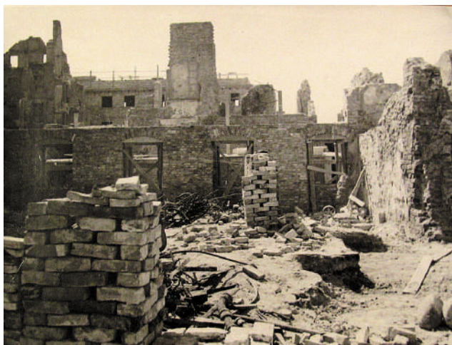
Dziedziniec Lapidarium w trakcie odbudowy, 1952 r.
