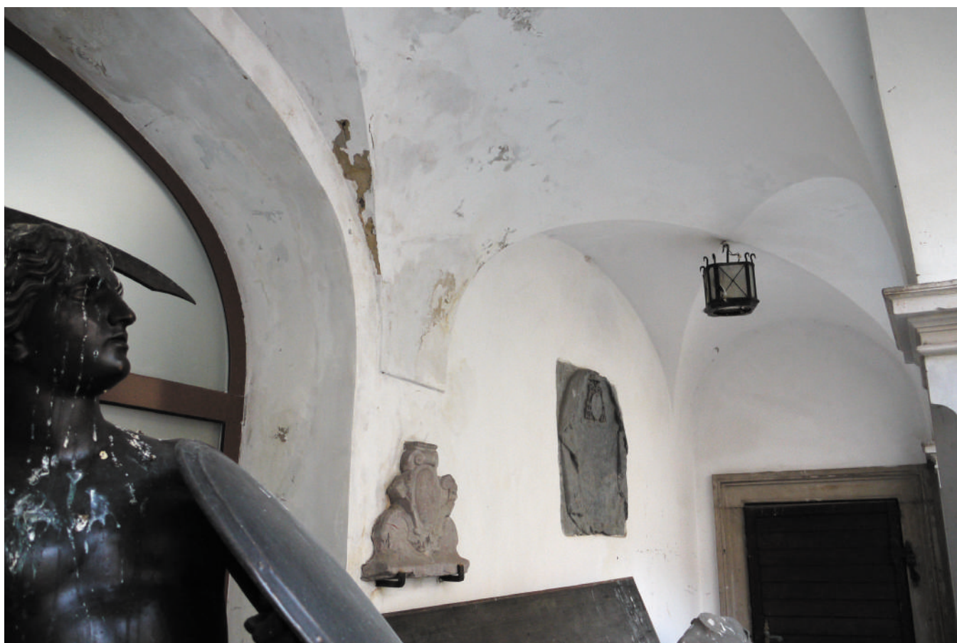
Lapidarium, elewacja N-E, detale - marzec 2013 r.
