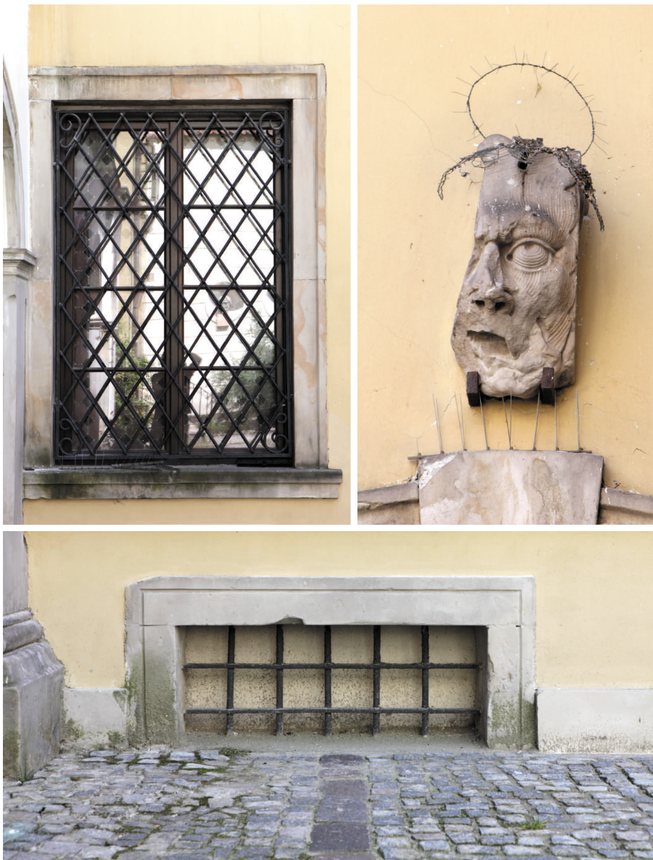
Lapidarium, elewacja S-E, detale, lipiec 2013 r.
