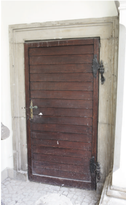
Lapidarium, elewacja N-E, detale - lipiec 2013 r.
