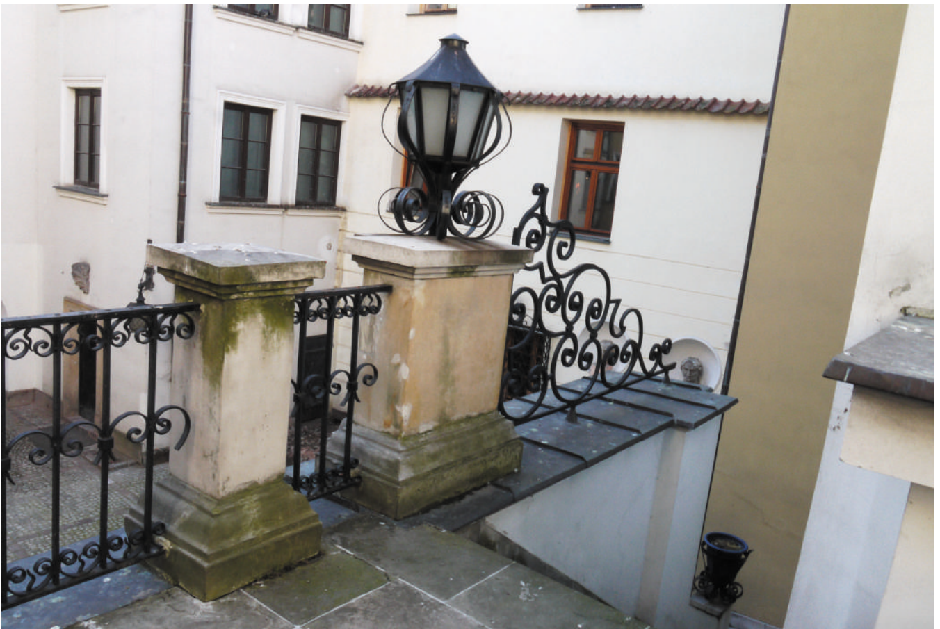
Lapidarium, elewacja N-E, detale - marzec 2013 r.
