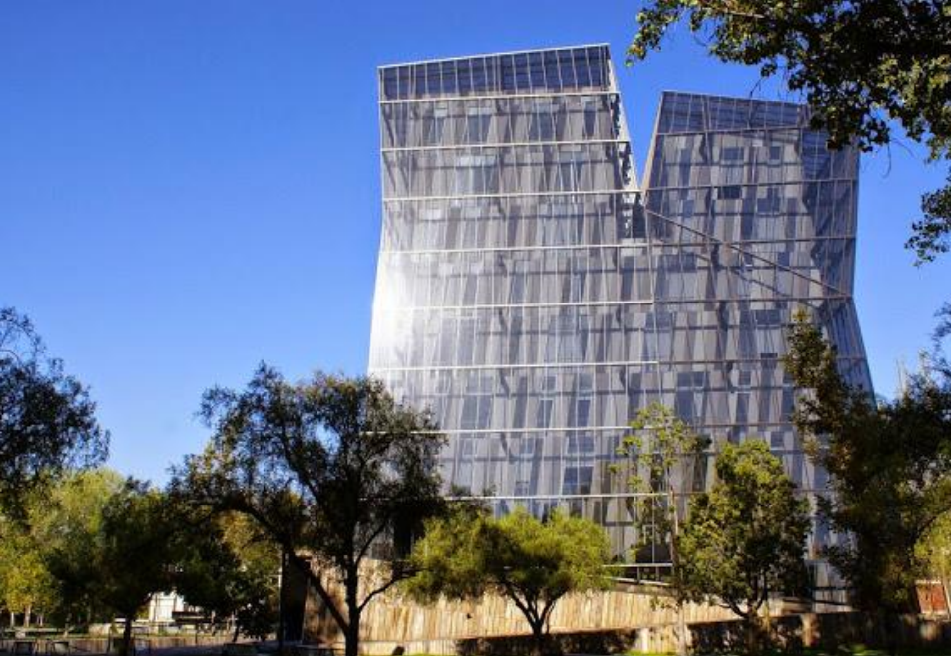
Wieżowiec śląski Uniw. Katolickiego (i dalsze fotografie)
