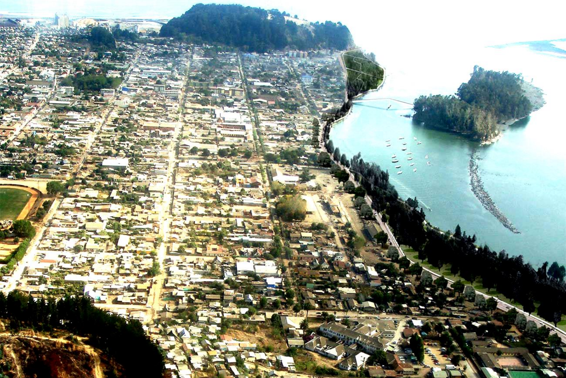
Constitucion. Tereny zniszczone falą tsunami w 2010 roku.
